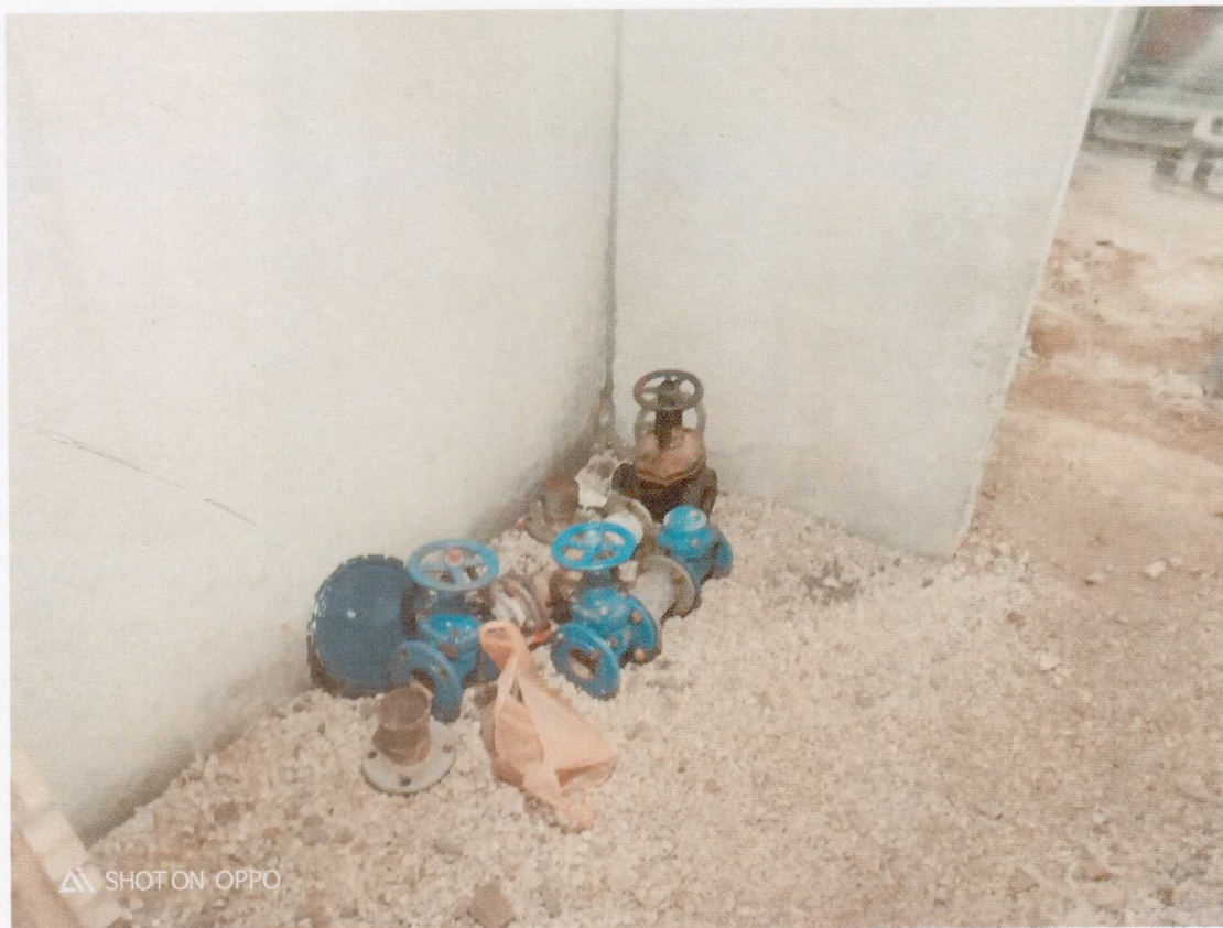
Узел ввода воды ХВС, 3 подъезд
